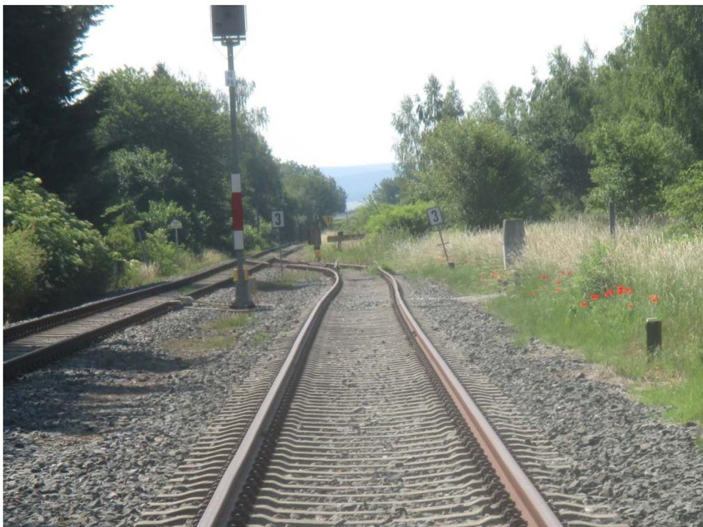
**Bild 9:** Stillgelegtes Gleis 808 mit Weiche 844; Stilllegung durch Rückbau der Schienen
