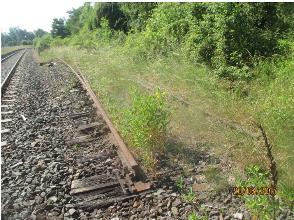
**Bild 10:** neben Gleis 808 befindliches, eingewachsenes Gleis in Höhe Bf Fröttstädt; nicht in Plänen verzeichnet
