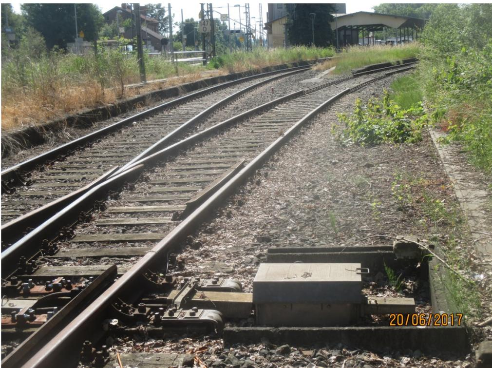
**Bild 4:** Weichenende der Doppelkreuzungsweiche 831, stillgelegt und als Flankenschutzweiche genutzt; im Hintergrund: Stilllegung des Gleises 808 durch Rückbau der Schienen
