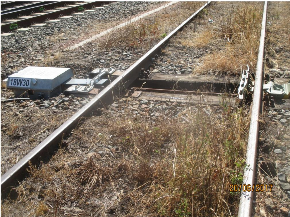
**Bild 2:** demontierte Zungeneinrichtung und Gleissperre am Gleis 864
