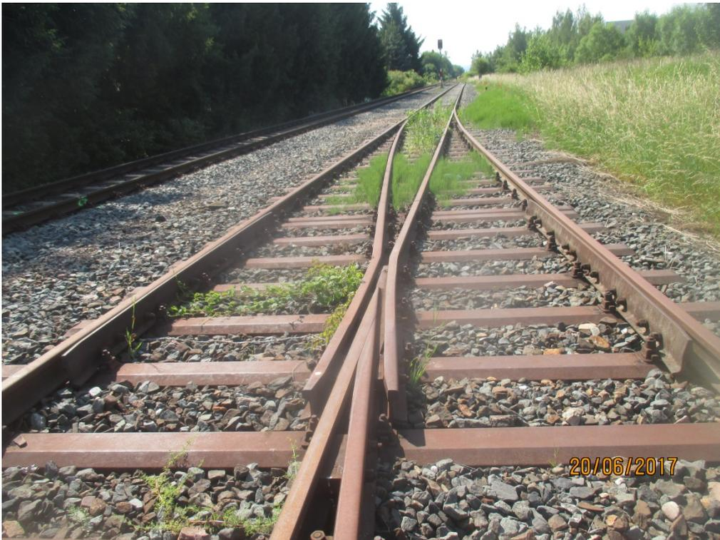
**Bild 6:** Weichenende der stillgelegten Weiche 842 auf Stahlschwellen
